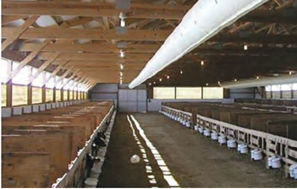
Şekil 4. Kapalı ahırda bakılan buzađılarda pozitif basınlı havalandırma sistemleri
